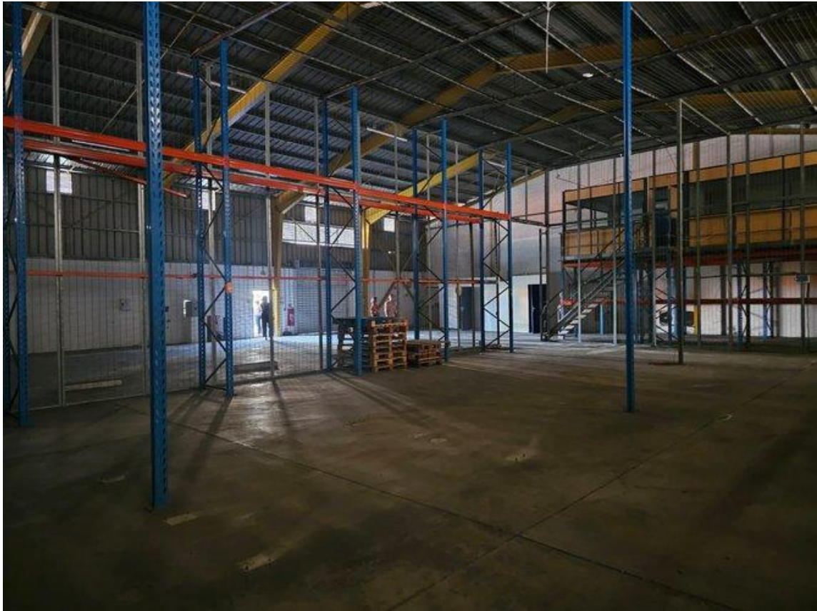
Vue intérieure — Entrepôt 599 m² · Hauteur libre 8 m · Racks · Mezzanine · ZI3 Saint-Pierre
