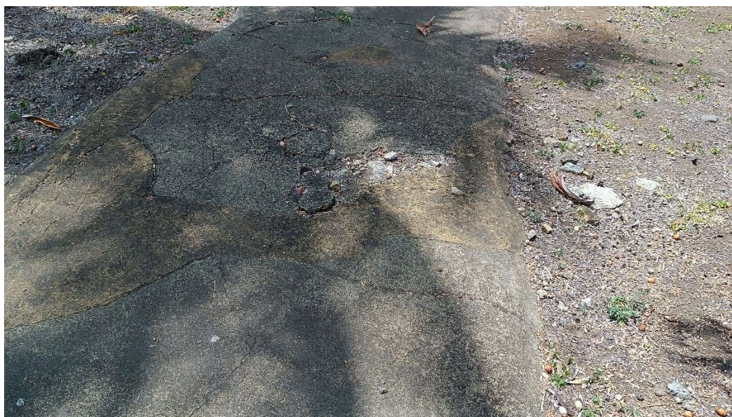
Exemple de zone ponctuelle nécessitant une reprise du revêtement du cheminement.
