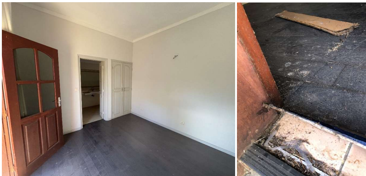
Lames vinyle posées sur carrelage d'origine (15/41) : En mauvais état
